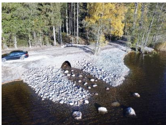
Figur 16. Halvtrumma Bredsjön med naturlig utloppströskel.
