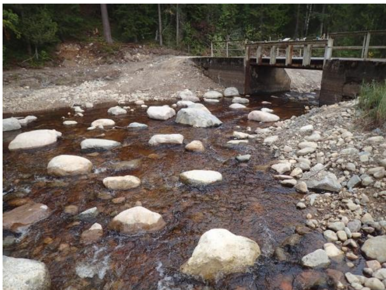
Figur 39. Vattenvägen nedströms tröskeln utformad som en naturlig bäckmiljö.
