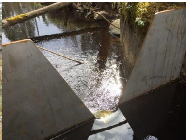
Figur 74. Överfall med V-profil i stålplåt.
