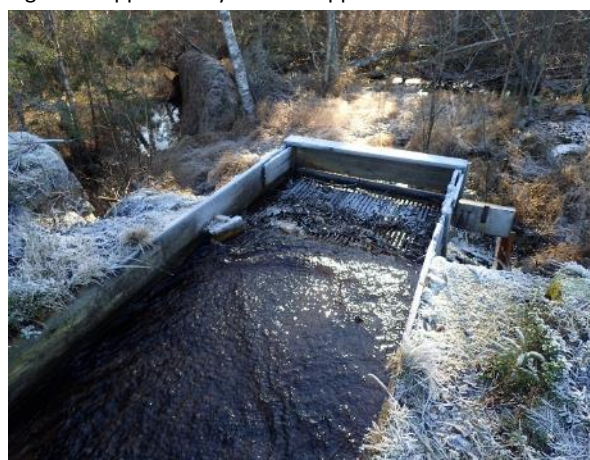
Figur 31. Tysktjärn höger utskov, skibord.
