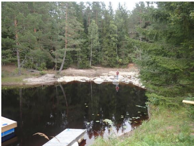
Figur 38. Ny utloppströskel Hammarskogsån där damm belägen strax nedströms rivits ut.
