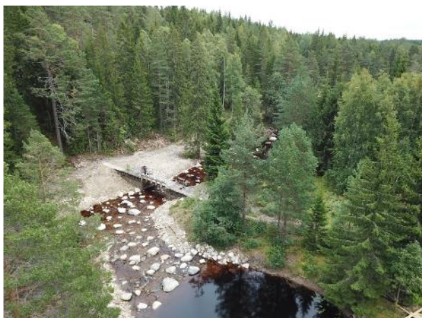
Figur 8. Exempel på partiell utrivning Gräntjärnsdammen och återställning av strömområdet.
