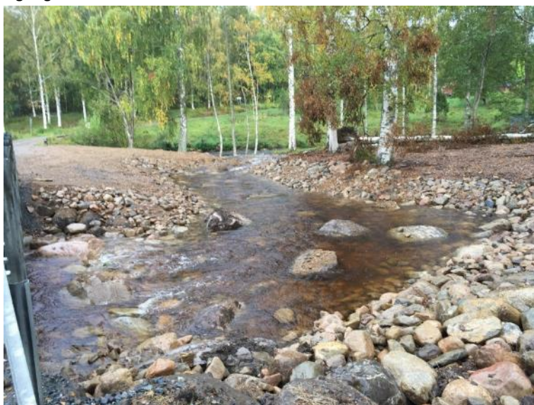
Figur 33. Vattenvägen nedströms tröskeln utformad som en naturlig bäckmiljö.
