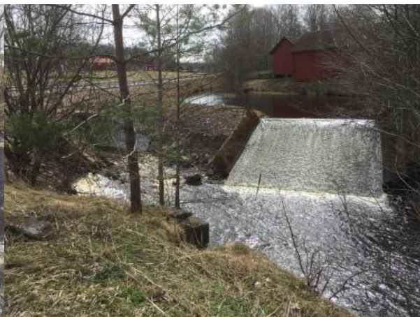
Figur 41. Skibordet till höger och vägkulvert för Varnan t.v.
