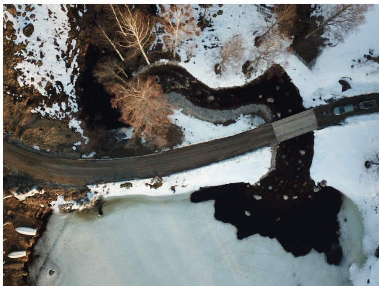
Figur 52. Exempel på omlöp vid Dammsjön. Vattennivån kunde med detta utförande bevaras nära intakt uppströms och omlöpet är så pass dimensionerat att hela sjöns avrinning kan avbördas. Kostnad ca 650 tkr.
