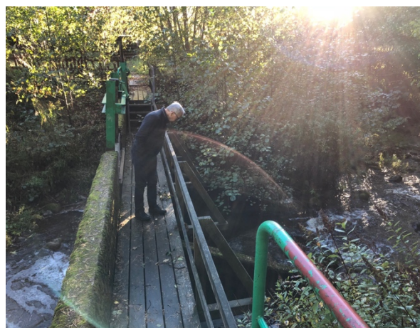
Figur 62. Över dammen löper smal gångbro.
