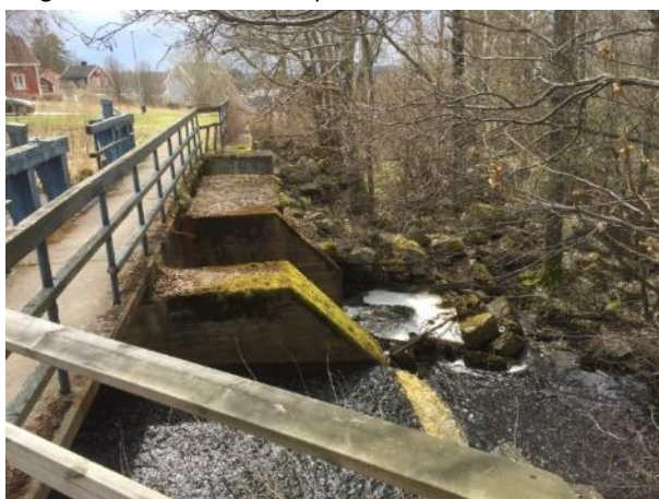
Figur 55. Utskoven, gångbro och brant åfåra nedströms.
