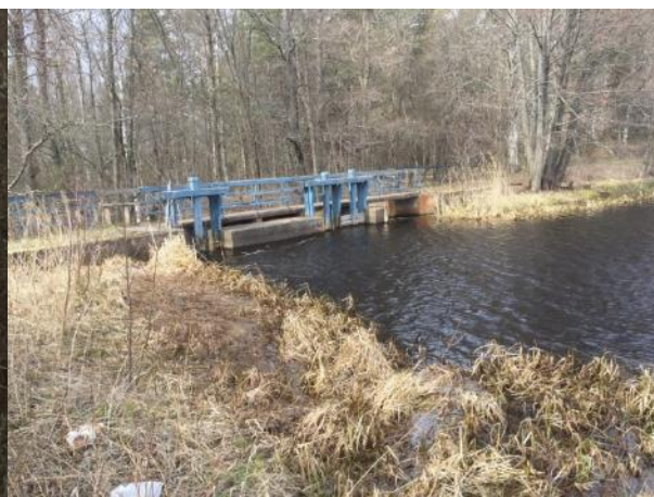
Figur 54. Dammfront (uppströms sida).
