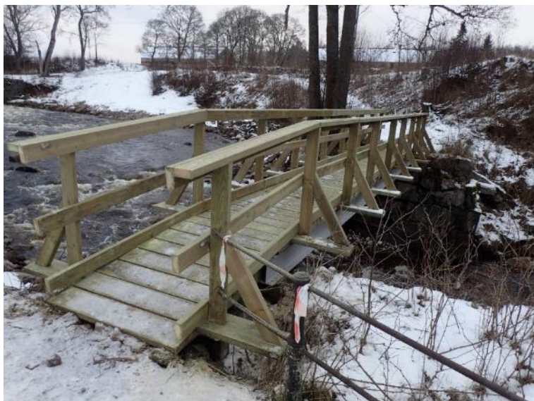
Figur 23. Gångbro över utrivet dammutskov.
