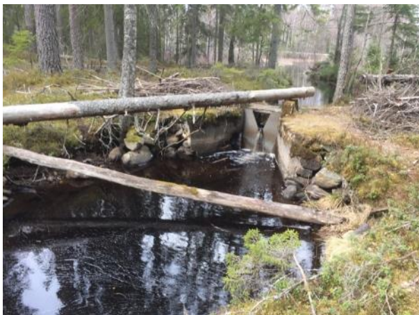
Figur 73. Utskovsdammen med självreglerande överfall.
