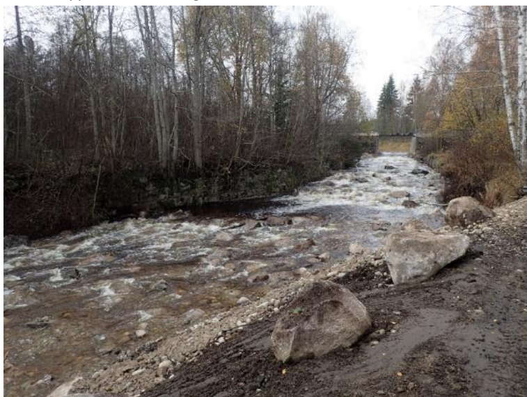
Figur 27. Nedströms samma damm. Notera bottenuppbyggnad som bidrar till att upprätthålla nivåer uppströms.
