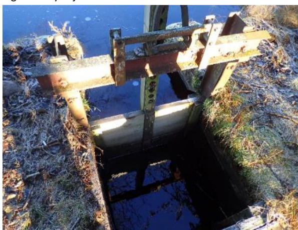
Figur 30. Tysktjärn vänster utskov, spettlucka.
