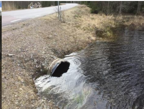
Figur 72. Vägkulvert strax uppströms dammen.
