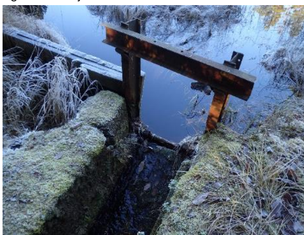
Figur 36. Mörttjärn vänster utskov, sättfack delvis blockerat.
