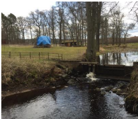
Figur 43. Skibord och lucka högra dammen
