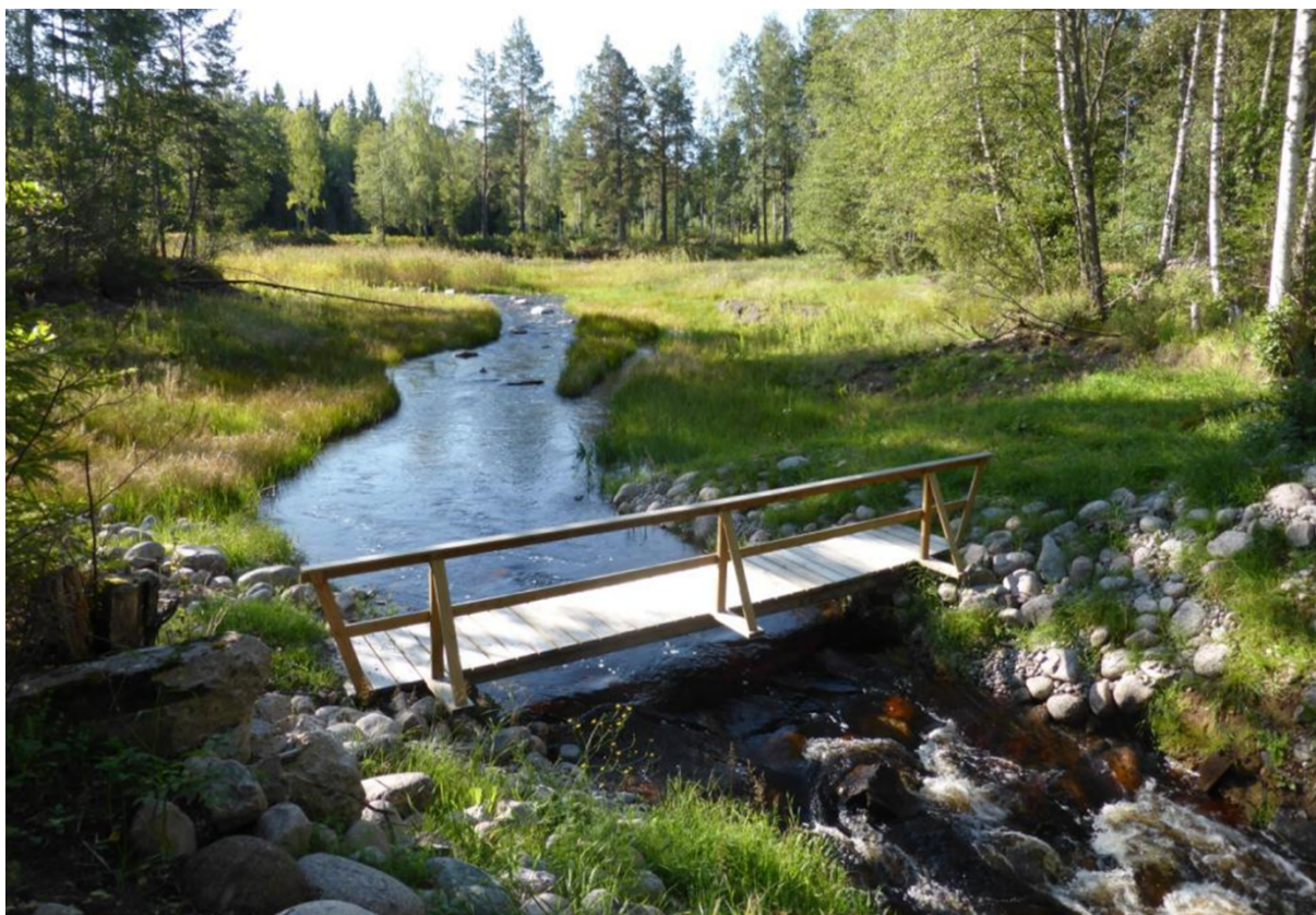
Figur 58. Exempel på utrivning Fräsebäcken. Ny gångbro anlades över dammläget.
