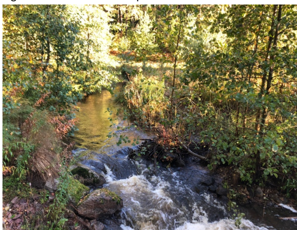
Figur 61. Uppströms dammen förekommer bottentrösklar i det avsänkta området.
