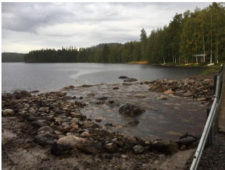
Figur 32. Ny utloppströskel Hammarskogsån där tidigare utskov på dammen lagts igen och ersatts av denna.
