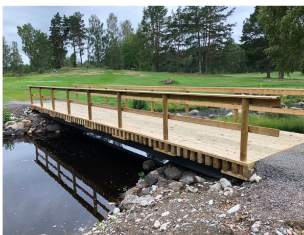
Figur 65. Ny gångbro i dammlägets närhet.
