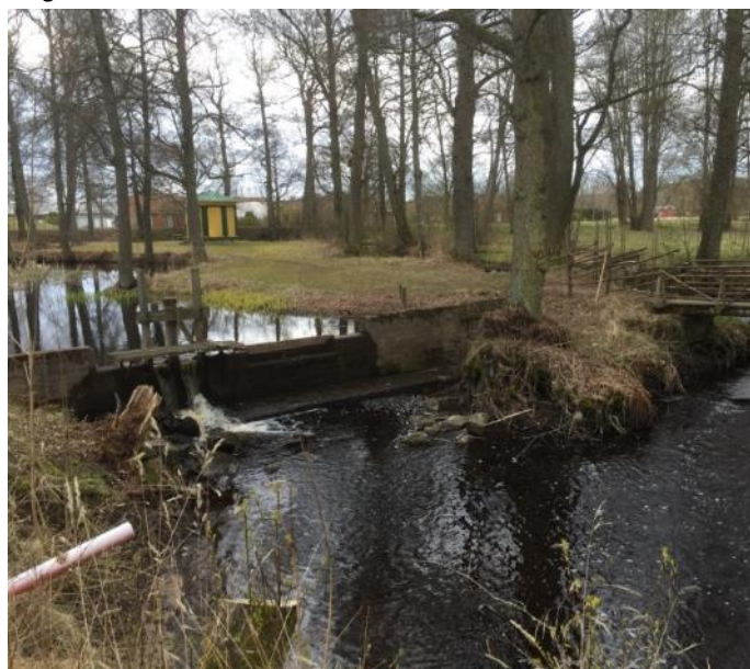
Figur 46. Skibord och lucka högra dammen vid sammanflödet.
