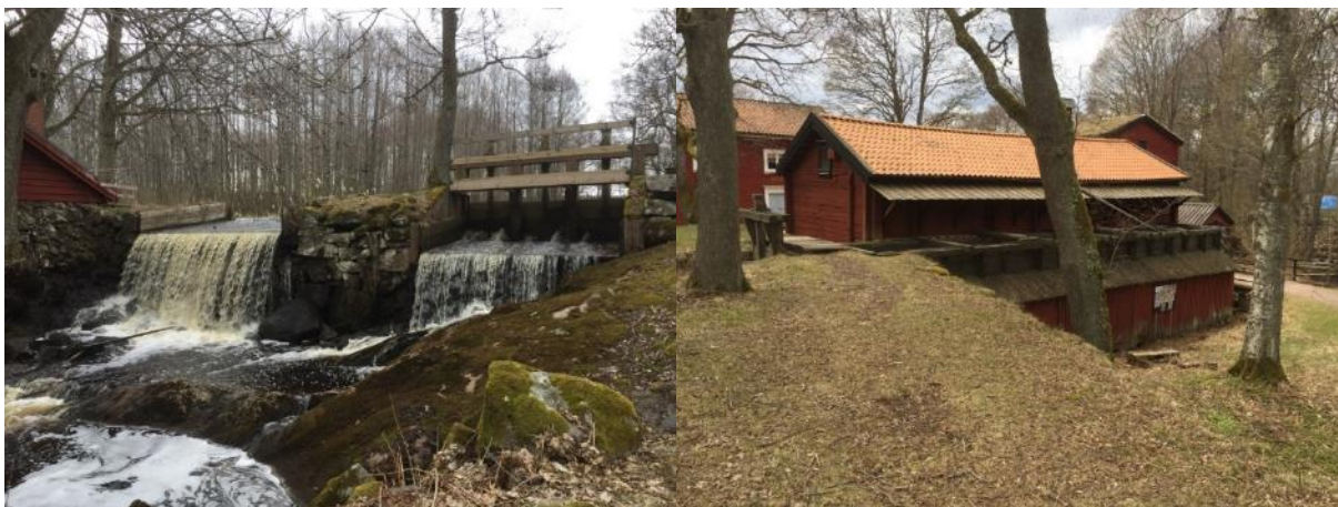
Figur 48. Skibord och lucka dammens utskovsparti i N del.
