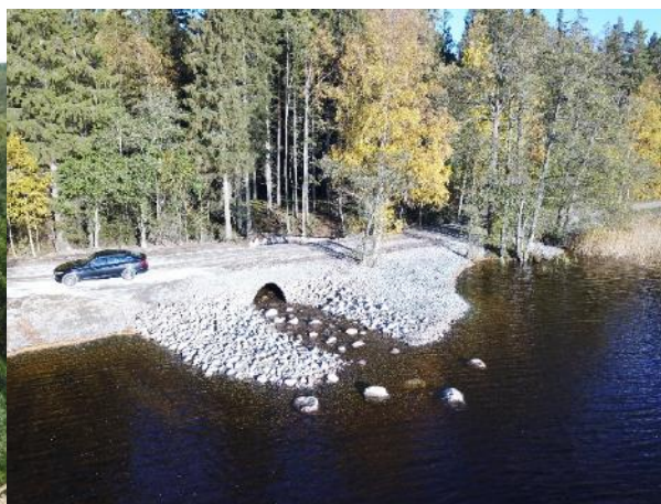
Figur 9. Exempel på utrivning och anläggande av strömnacke för reglering av Bredsjön.
