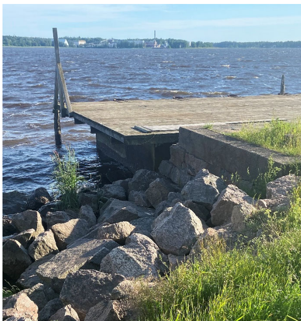
Figur 4 Brygga med trä- och stålbalkar på ett Betongfundament
