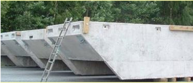
Figur 13 Exempel på flytande vågbrytare.
