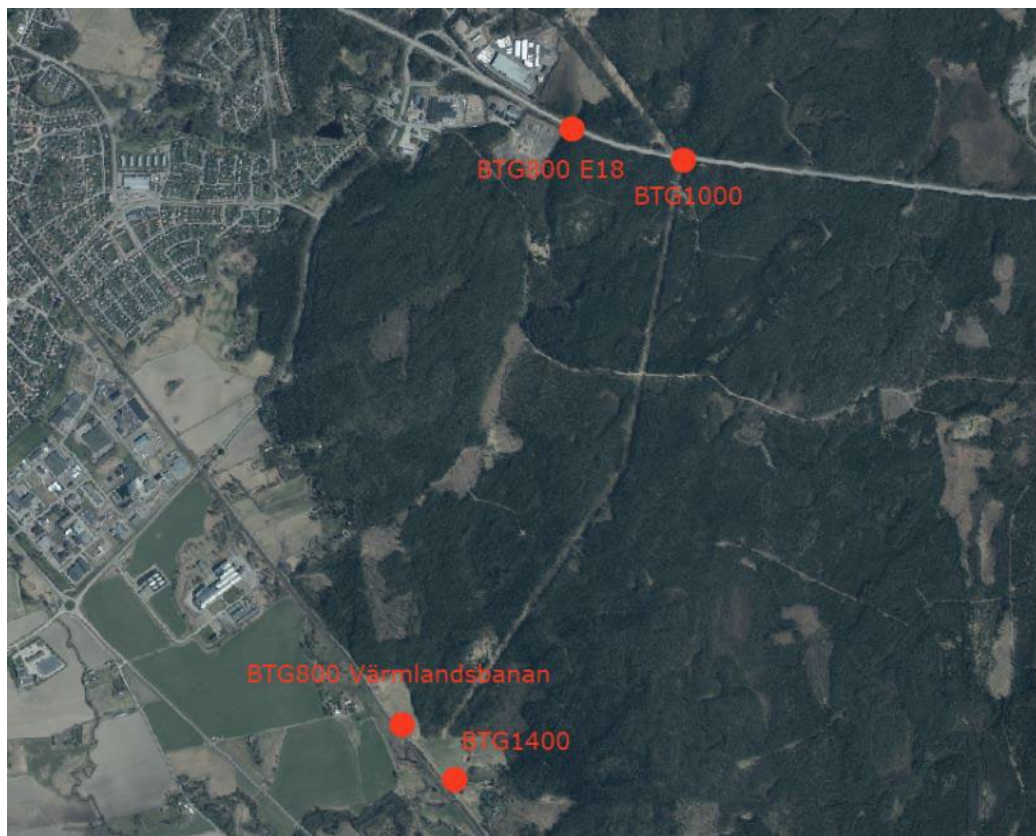
Bild: Befintliga trummor under E18 och Värmlandsbanan.
