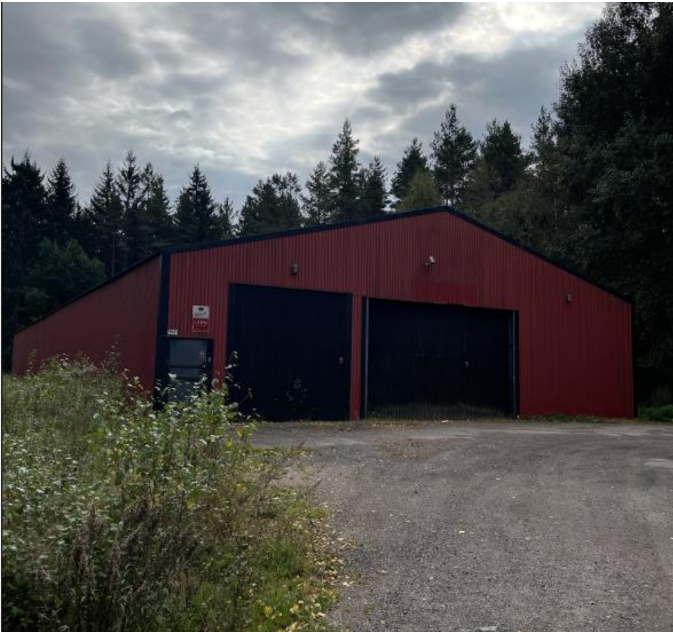
Foto: Befintligt kallförråd.
