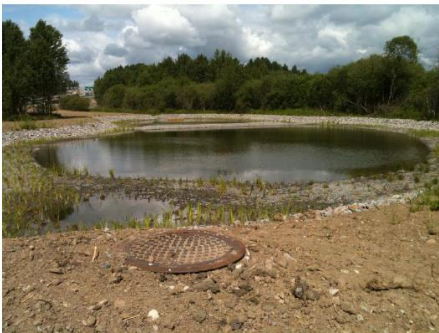
Foto: Exempel på dagvattendamm med vattenspegel längs med E18 (Foto: Sweco). Dagvattenutredning A9, Harberget Kristinehamn Fortifikationsverket, Sweco 2024-06-26.
