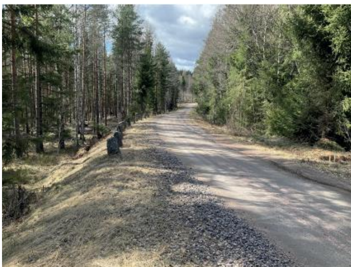
Bild: Räckesstenar invid den äldre landsvägen söder om regementsområdet. Arkeologisk inventering inför detaljplan vid Harberget, Kristinehamns kommun, Värmlands län, Sweco 2023-05-12.
