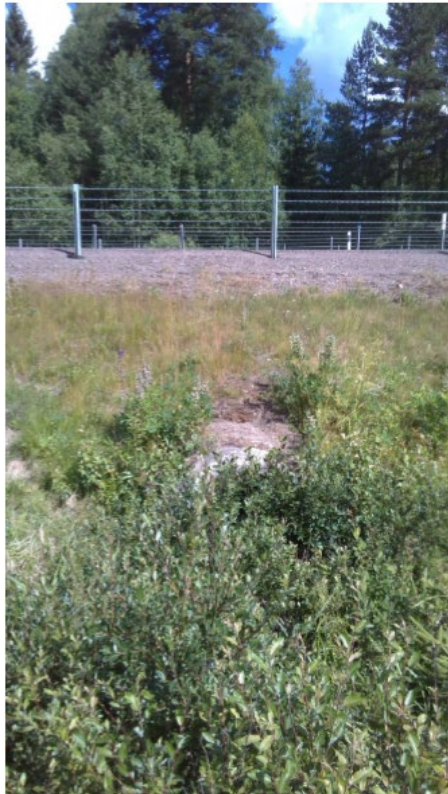
Foto: BTG1000 under E18. Rensning av sly vid inloppet kan komma att krävas (Foto: Kristinehamns kommun, juni 2023). Dagnattenutredning A9, Harberget Kristinehamn Fortifikationsverket, Sweco 2023-08-29.
