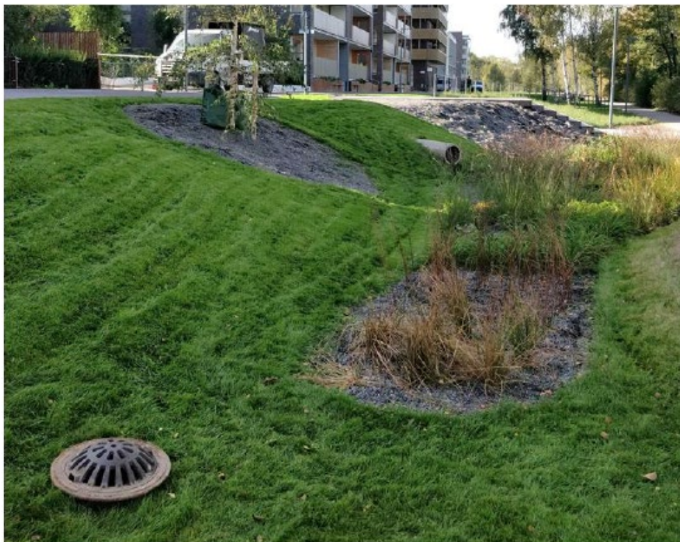
Foto: Exempel på hur en fördröjningsyta för ytv rinnande vatten kan utformas. Kupolbrunn i botten (foto: Sweco). Skyfallsutredning Regemente A9 Kristinehamn Sweco 2023-08-29.
