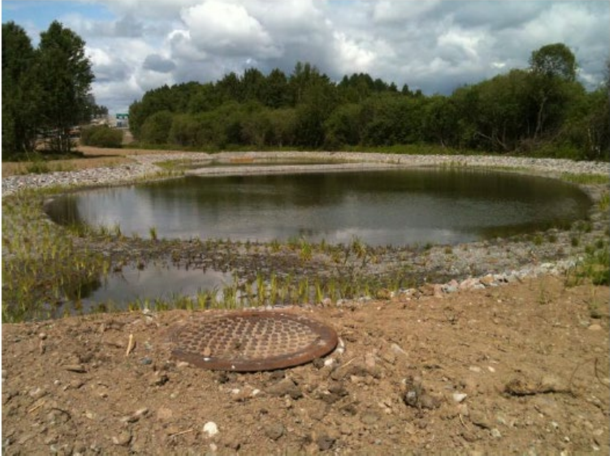
Foto: Exempel på dagvattendamm med vattenspegel längs med E18 (Foto: Sweco). Dagvattenutredning A9, Harberget Kristinehamn Fortifikationsverket, Sweco 2023-08-29.
