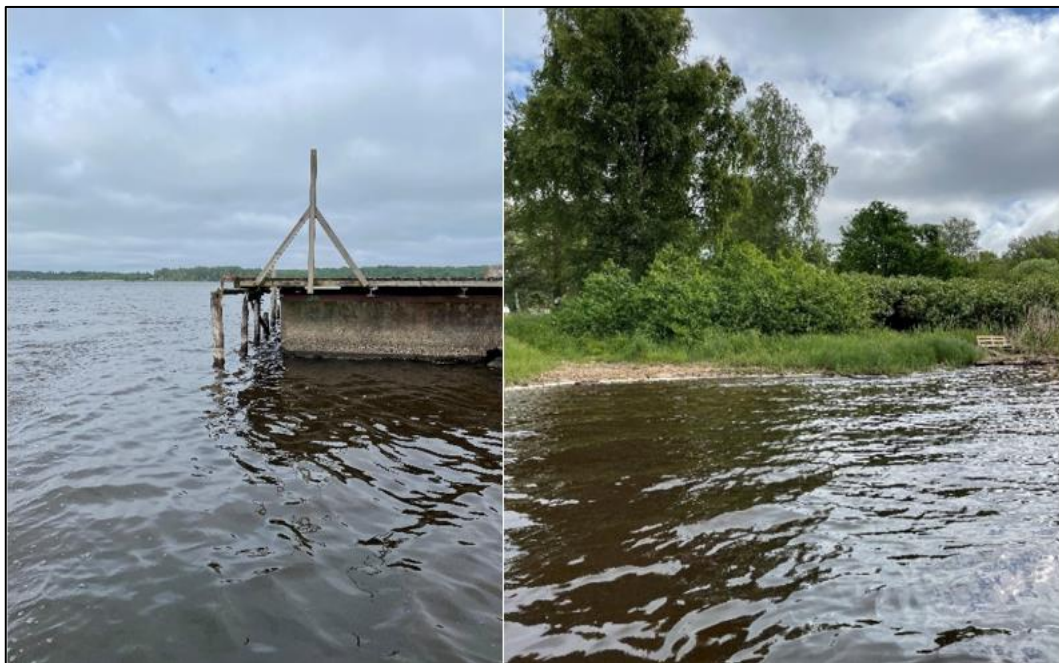
Figur 2. T.h. Kolbryggan. T.v. Stranden mot delarna av detaljplaneområdet, Marieberg Strand, på land. Källa: AFRY
