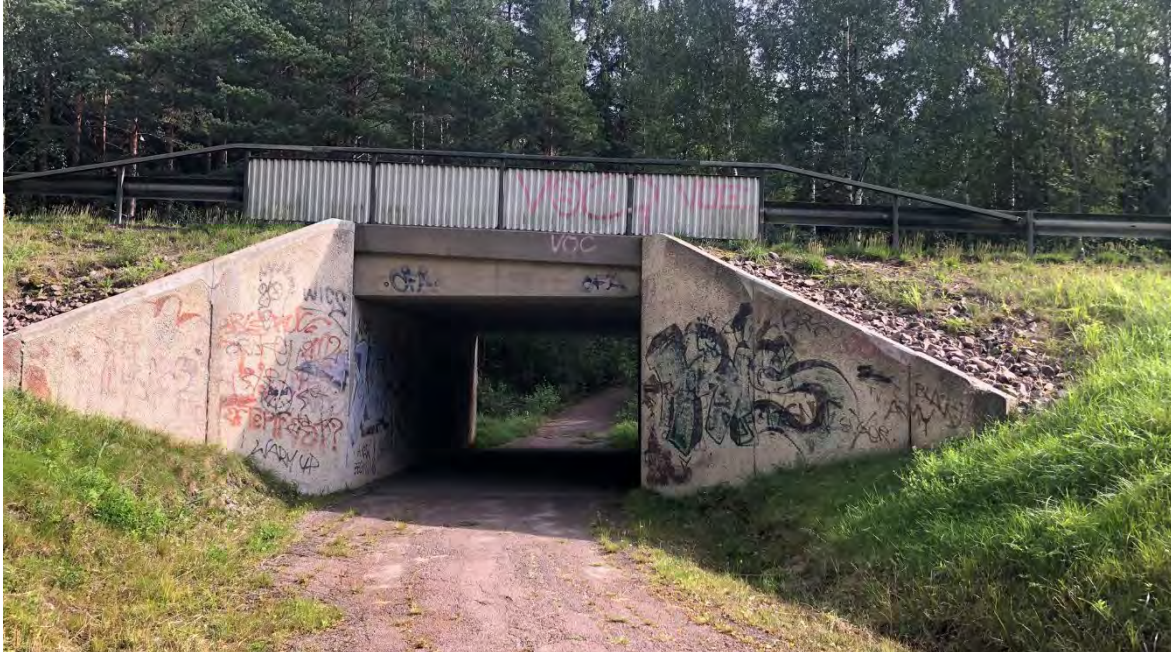
Figur 208 Befintlig gång och cykelbana under väg 26 genom "Norra Porten". Foto: Per Bergström Jonsson, Sweco 2023
