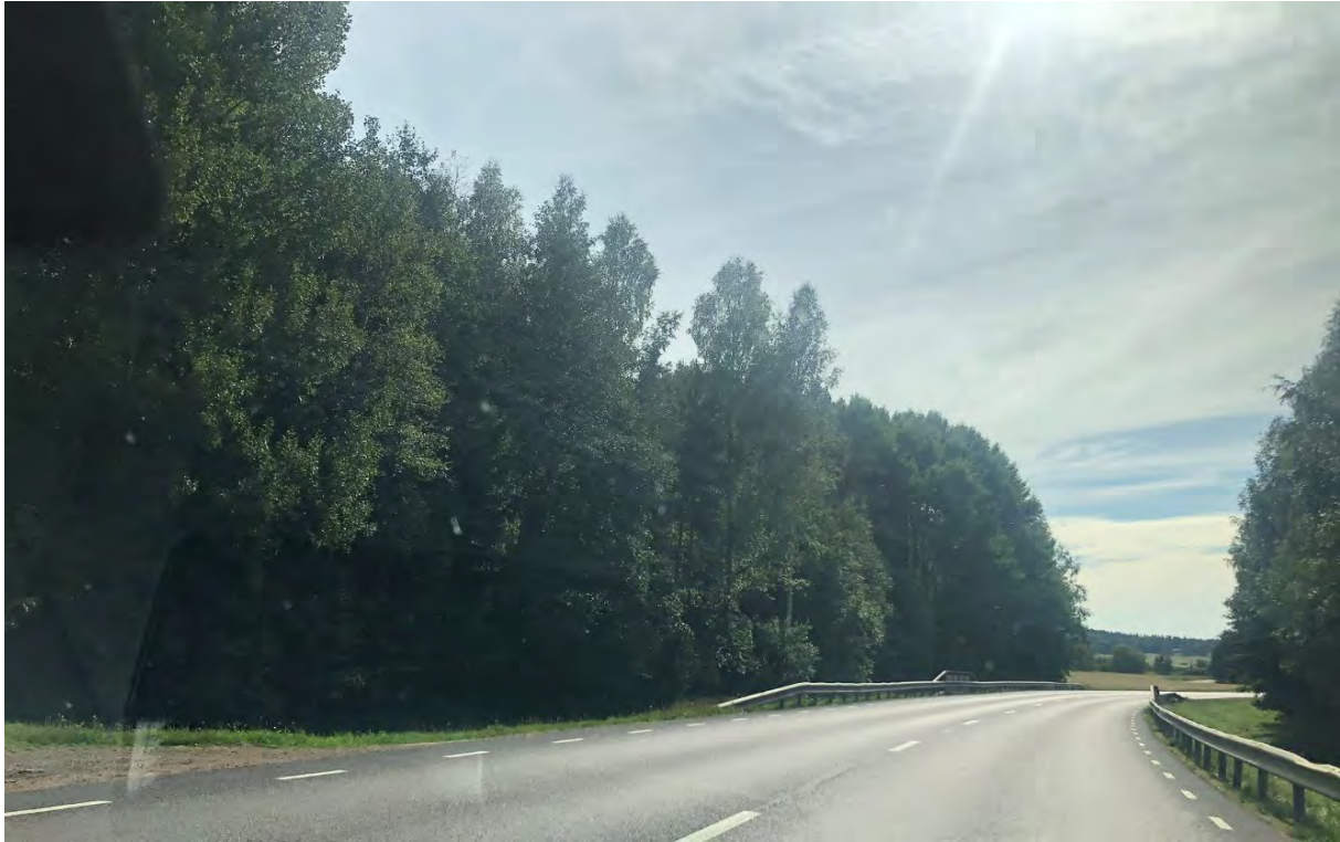
Figur 131 Väg 26 på den plats där vi föreslår en södra infart till Harberget. Fotot är taget i riktning söderut, infarten hamnar därmed åt vänster i bild. Foto: Per Bergström Jonsson, Sweco augusti 2023
