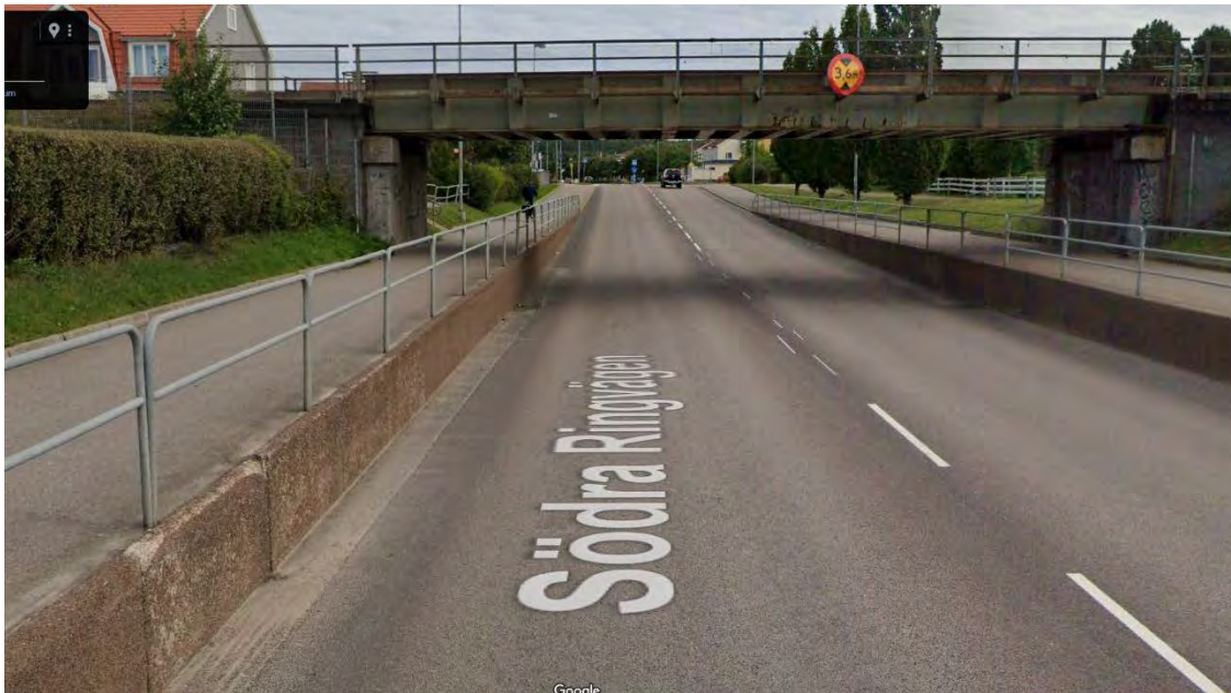
Figur 225 Höjdhinder på Södra Ringvägen. Foto från Google Streetview, mars 2024.
