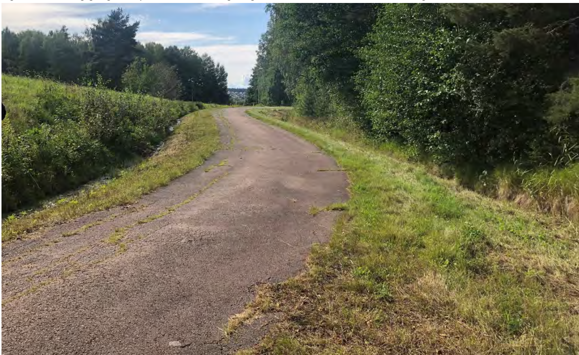
Figur 209 Befintlig gång och cykelbana väster om väg 26. Foto: Per Bergström Jonsson, Sweco augusti 2023
